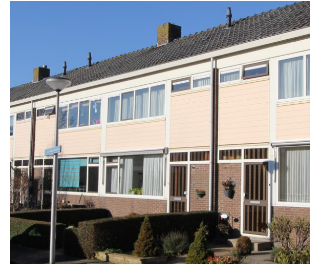
S. van Abcoude laan voor de renovatie
