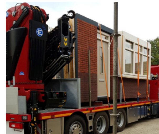
Aankomst en plaatsing van een prefab deel
