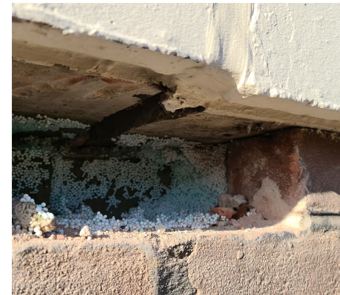
Spouwmuurisolatie achter een verwijderde steen
