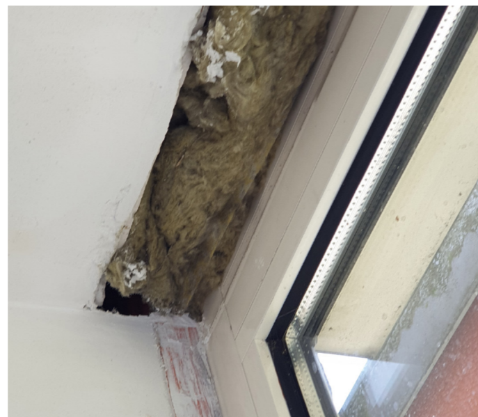
Spouwmuurisolatie achter een opengemaakt kozijn
