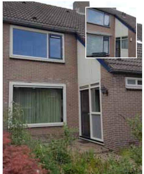
Bloemhofplein, Zuidland. Nieuwe kozijnen geplaatst.
