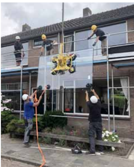
Mr. P.J. Oudweg, Zuidland. Vervangen van de ramen.
