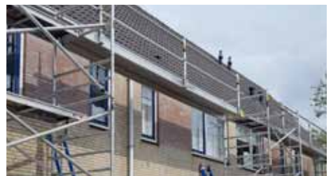
Burg. H. van Geestlaan, Zuidland. Dakgoten vervangen.
